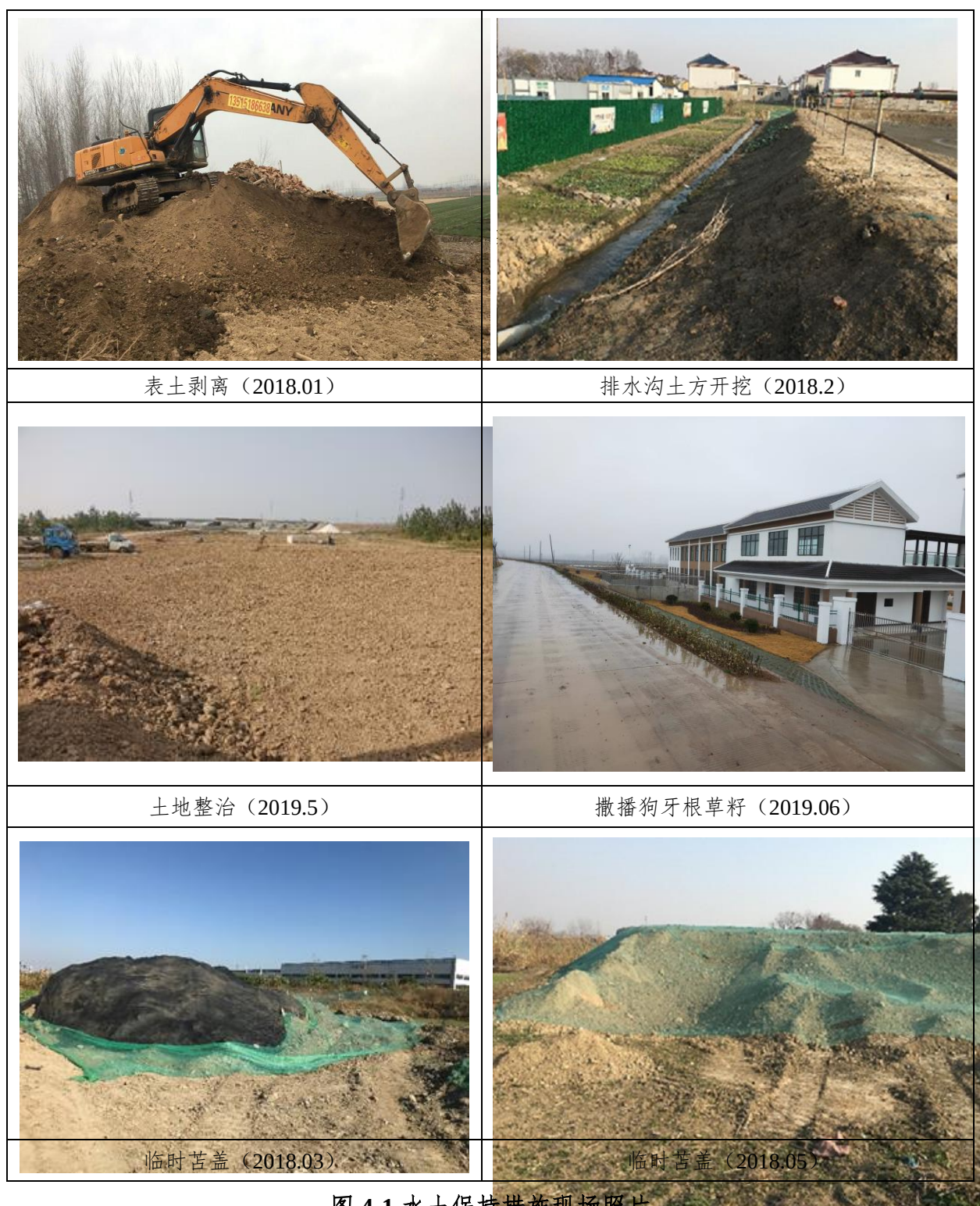
图 4-1 水土保持措施现场照片
